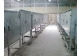
Tủ mạ kẽm nhúng nóng/ Hot dipped galvanized cabinet
