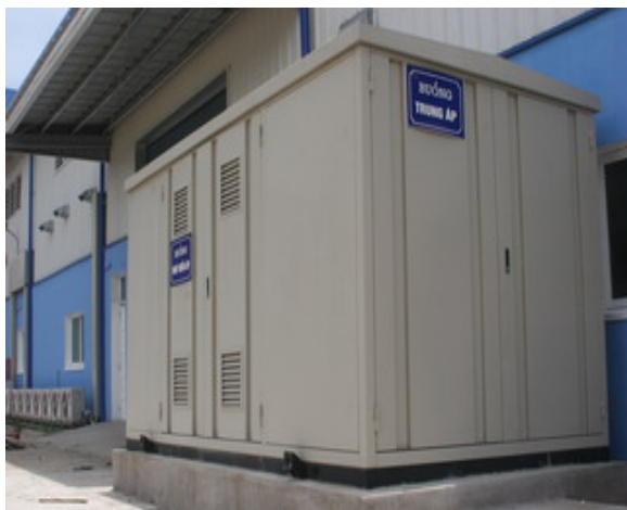
Lắp đặt trạm điện Kios/Installation of electrical Kios
