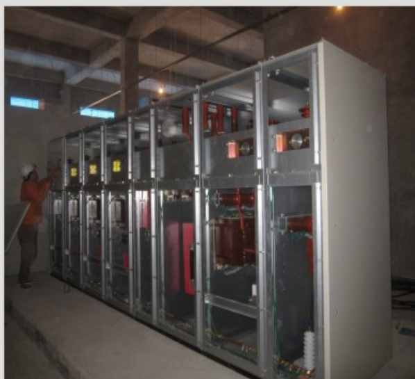
LẮP ĐẶT TỦ TRUNG THỂ - TỦ ĐỘNG LỰC- TỦ ĐIỀU KHIỂN
