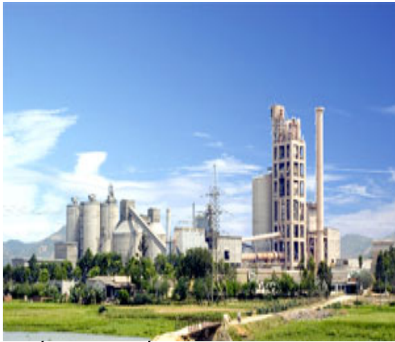
Cung cấp vật tư thiết bị điện cho nhà máy Xi măng Hoàng Mai- Nghệ An/ Provide electrical supplies and equipment for cement plants Hoang Mai Nghe An
