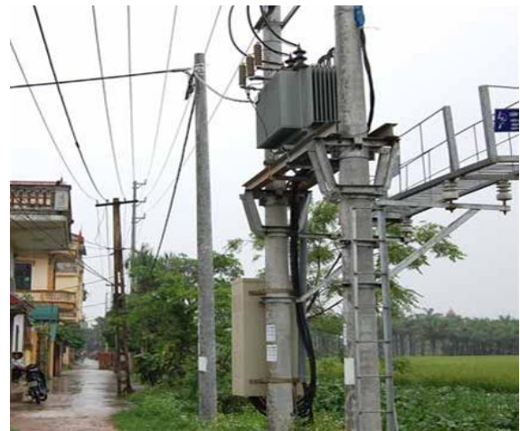
Xây lắp đường dây và trạm biến áp nhà máy bia khu công nghiệp từ liên, Hà nội/ Construction of transmission lines and substations brewery integrity IPs from Hanoi
