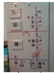
Tủ điều khiển bảo vệ/Protective control cabinet
