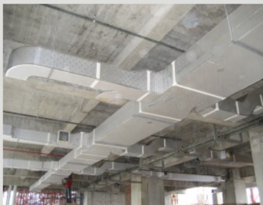
Hình ảnh thi công hệ thống điều hòa thông gió tại công trình
